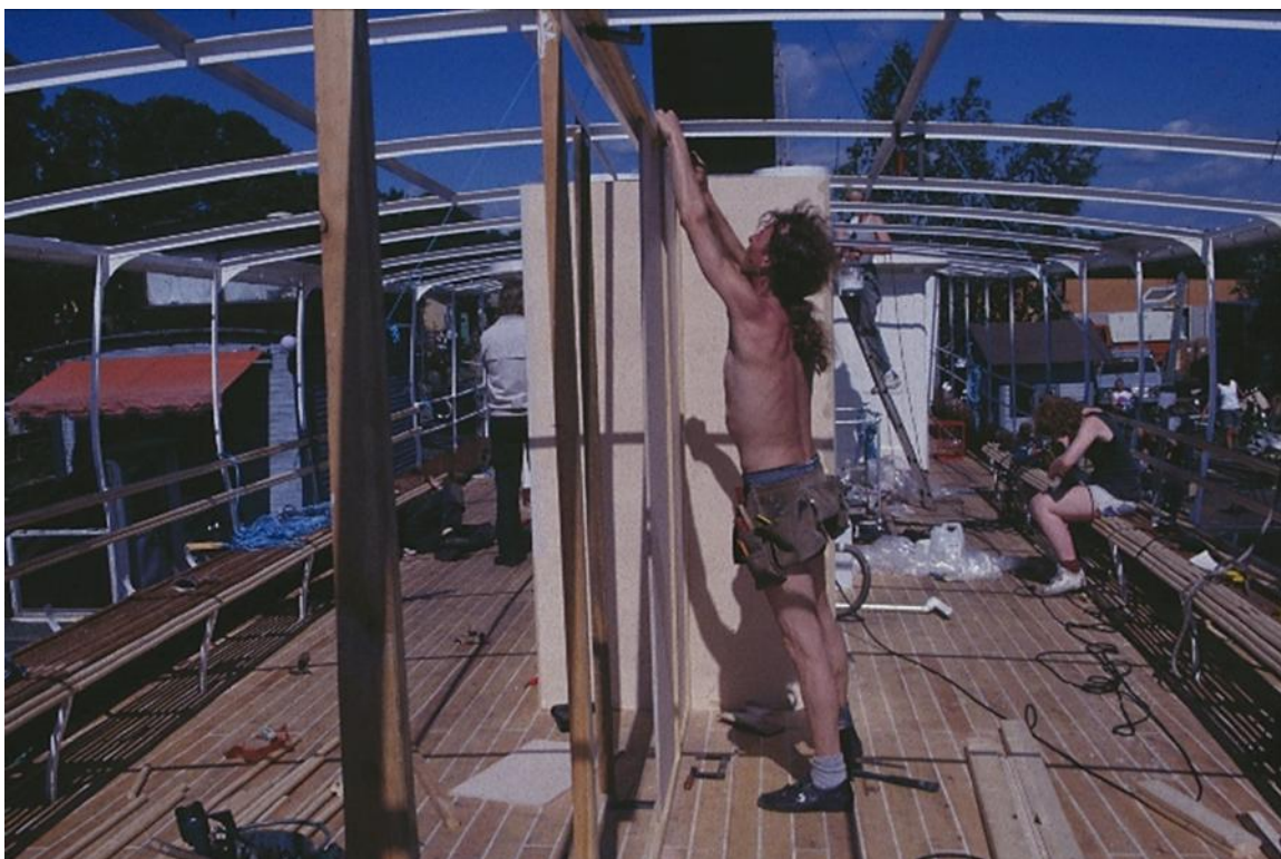
Foto från 1994 visande pågående arbeten på bryggdäck. Det ljusa däcket ser helt nyfernissat ut och det är utfört med breda vita nåt, samma utförande som återfinns invändigt i däckshuset idag.
