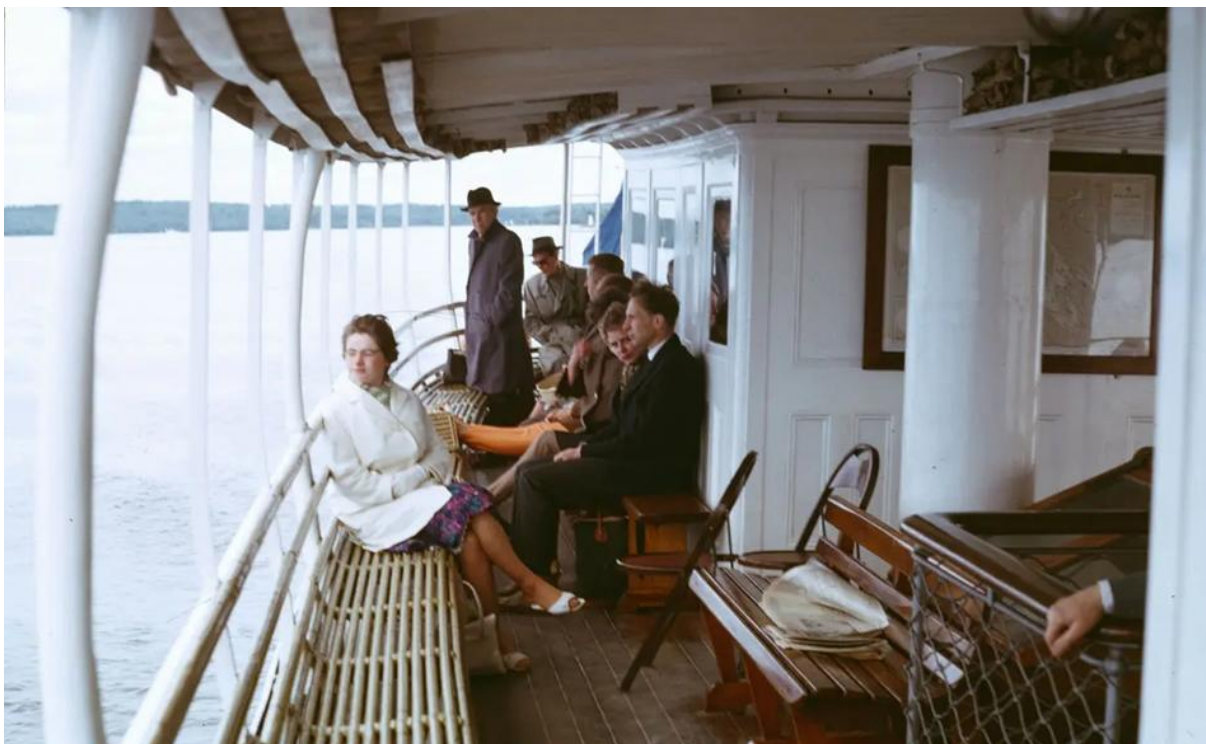
Foto från 1963 visande en del av bryggdäck. Däcket är mörkt rödbrunt och utfört med vita nåt. Förmodligen är däcket ett fernissat furudäck som drevats och förseglat med nåtkitt.
