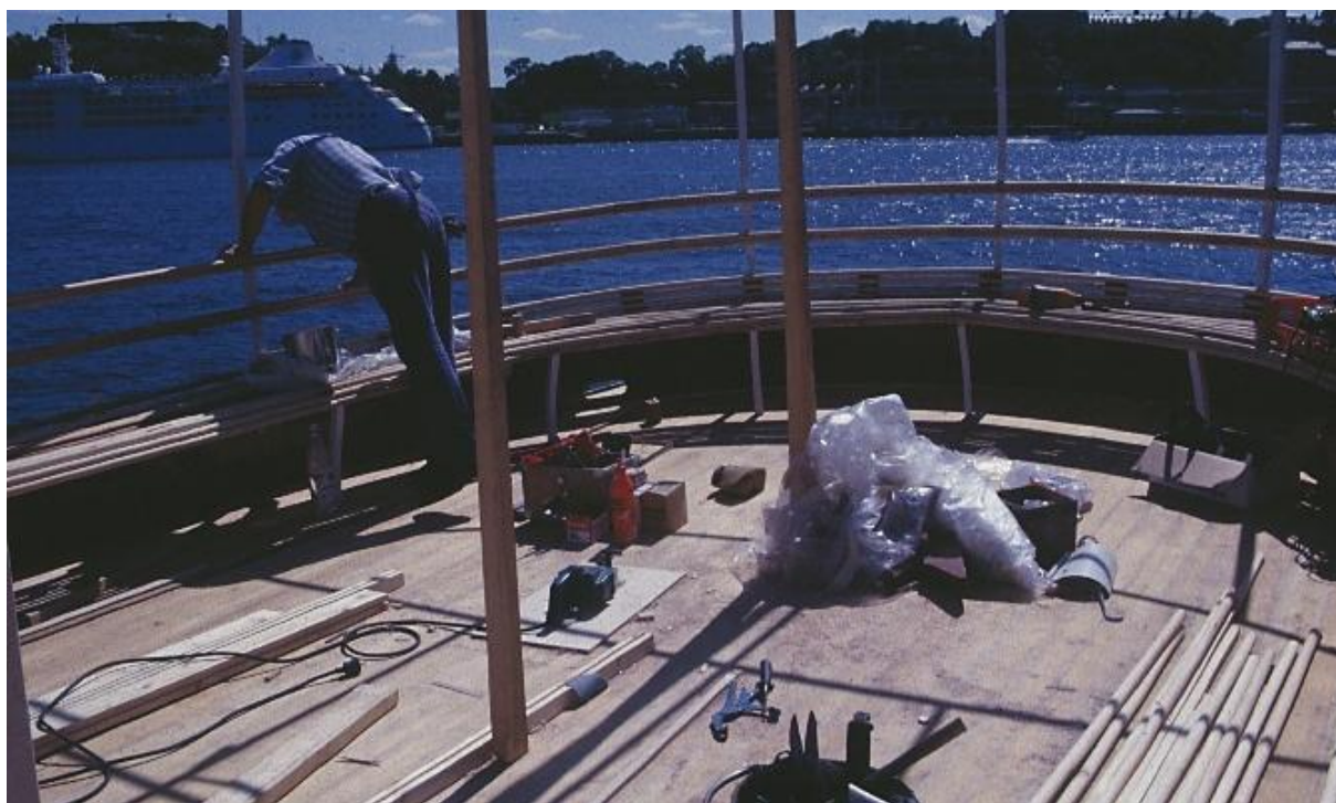
Foto från 1994 visande pågående arbeten på bryggdäck. Den återuppbyggda spjälsoffans träribbor tycks vid tillfället antingen vara omålade eller ljusst målade, kanske i en liknande kulör som den på färgfotot från 1963.
