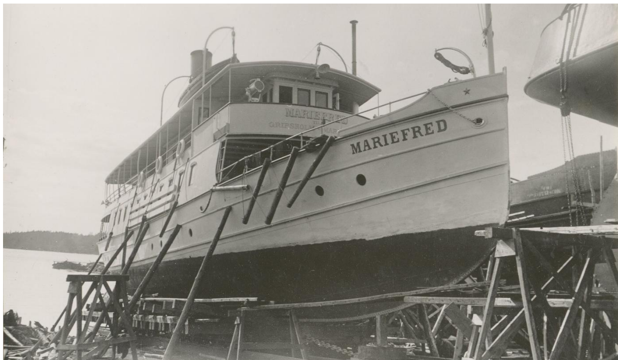
Foto från 1910 visande Mariefred slipdragen på Ekensbergs varv. Avbärrarlisten har en blank, jämn och mörk kulör vilket tydligast syns på den del av listen som är närmast fören.
