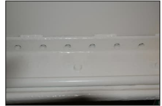
Detalj av stålbalk med inskription
